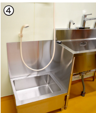
④調理用長靴を洗浄するシンク ⑤キッチンで作られた料理を保管スペースに移す際に異物混入を防ぐ2重開閉扉 ⑥大鍋からスムーズに排水できる排水口 ⑦ホコリの侵入を防ぎ掃除がしやすいHACCP（※）対応の照明 ※ HACCP（ハサップ）とは「Hazard（危害）」「Analysis（分析）」「Critical（重要）」「Control（管理）」「Point（点）」という言葉の略語で、食品を製造する際に安全を確保するための管理手法のことを言います。
