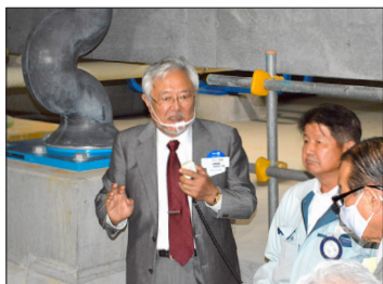
地下に移動して免震装置を見ながら 中山所長の解説を聞きます
