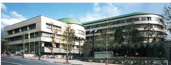
転機となった別府市庁舎工事。この後、別府ビーコンプラザ、キャノン大分、立命館アジア太平洋大学、別府アリーナなど数々のビッグプロジェクトに関わるようになりました。
