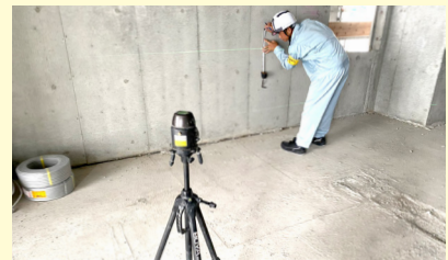
壁に基準レベルのレーザーを照射
