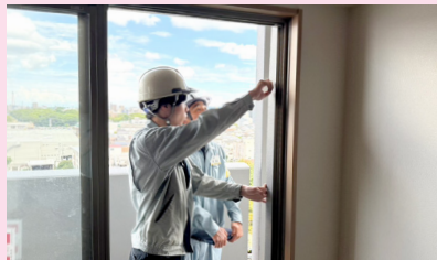
外回りのサッシの仕上がりを確認
